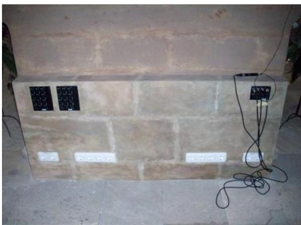
Denn hier, in diesem Anschlusskasten, musste das Kabel ankommen! Die Holzkonstruktion wurde als Sandstein getarnt und fügt sich unauffällig ein.
