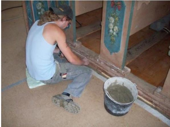
Eingebaut waren die Bänke verhältnismäßig schnell. Aber damit hatte die Arbeit an ihnen erst begonnen. Hier werden die Fugen am Boden zwischen Sandsteinbelag und dem Bankpodest geschlossen.
