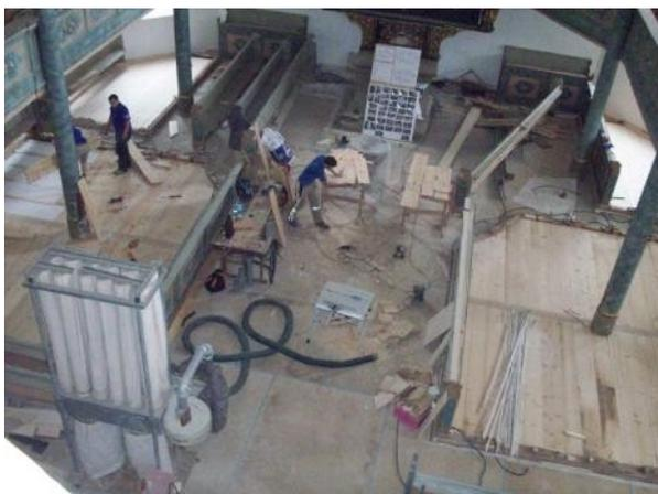
Hier das Ganze noch einmal von oben! Links unten im Bild ist die Absauganlage erkennbar, die dafür sorgen sollte, dass der feine Sägestaub nicht gleich wieder die schon fertigen Teile der Kirche verschmutzt.
