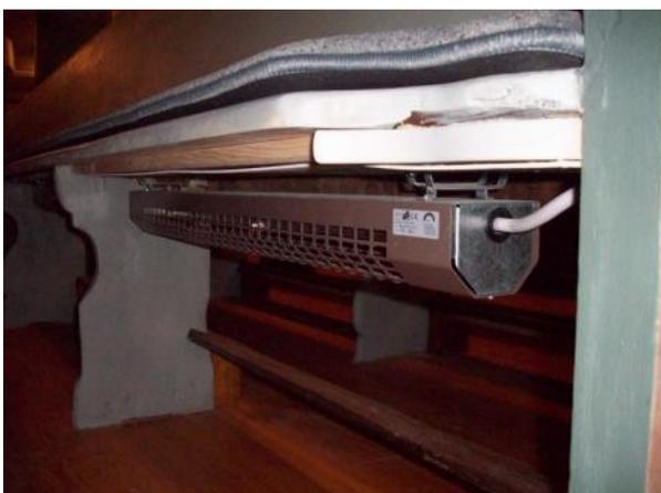
Dieses Heizelement ist bereits fertig montiert. Damit sich niemand am heißen Heizstab verbrennen kann, schützt ihn die Abdeckung.
