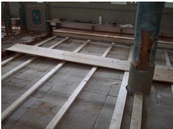
Vor den Bänken mussten aber zuerst noch die Bodenbretter eingebaut werden. Auf dem Bild ist deutlich erkennbar, wie ausgetreten der alte Sandsteinboden unter den Querlatten ist!
