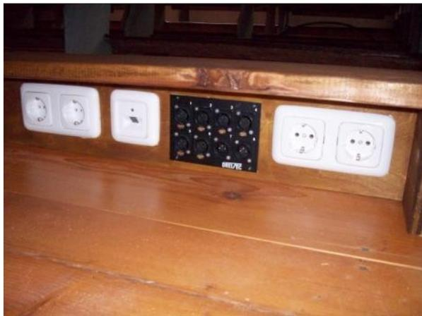
Sehr viel später das Ergebnis: Steckdosen in ausreichender Anzahl, dazwischen Mikrofon-Anschlüsse (schwarz) und eine Datenleitung, die einen Beameranschluss ermöglicht – alles sauber eingebaut!
