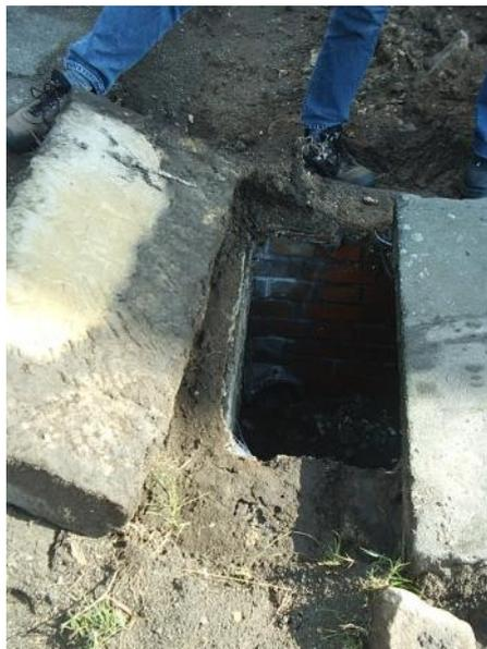
Durch diesen Schacht wurden die Rohre untersucht. Leider waren sie größtenteils defekt, was bedeutet, dass um die Kirche herum aufgegraben werden muss, um sie zu ersetzen.
