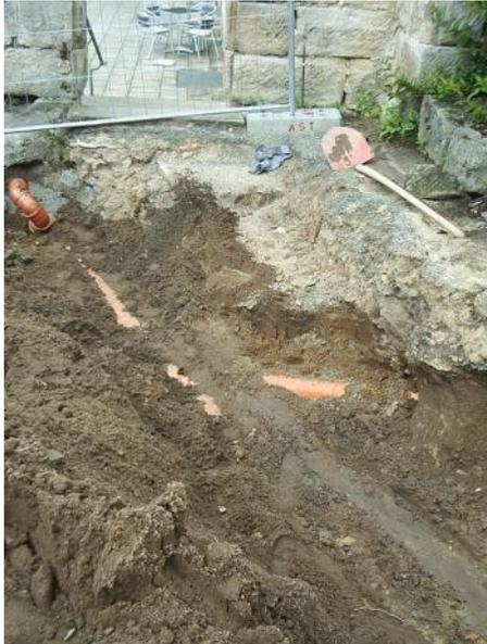
Hier ist der Verlauf der Entwässerungsrohre in Richtung Schlossplatz erkennbar. Hier mündet alles in den bestehenden Kanal.
