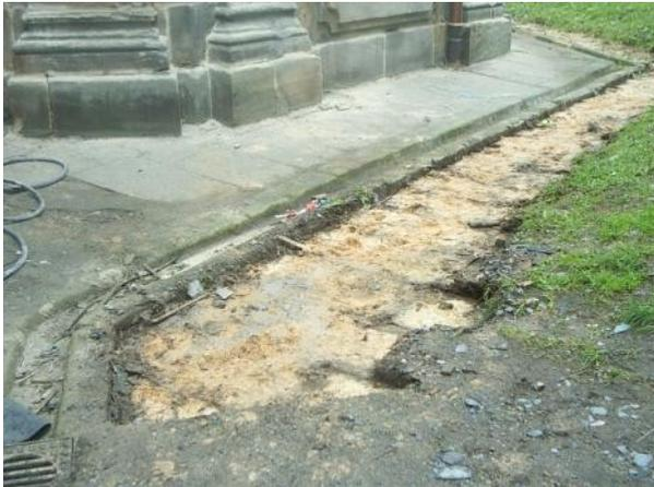
Unsere Kirche verfügt schon immer über ein eigentlich vorbildliches Entwässerungssystem: Über schräg gestellte Platten wird das Wasser vom Gebäude weg in umlaufende Rinnen geleitet und von dort in den Kanal. Auf diese Weise bleibt das Fundament trocken – eine Seltenheit bei alten Kirchen.
