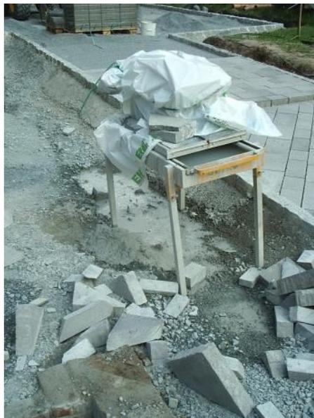
Eine besondere Herausforderung für die Pflasterer sind die Kurven und der diagonale Verlauf der Zeilen. Hier müssen viele Steine genau zugeschnitten werden.
