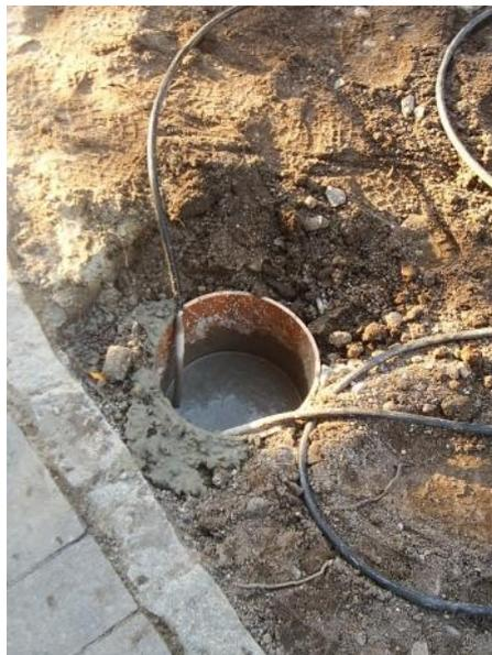
Für den Bereich hinter der Kirche wurden einfache Pollerleuchten als Wegebeleuchtung vorgesehen. Hier wird ein Fundament für den sicheren Stand betoniert.
