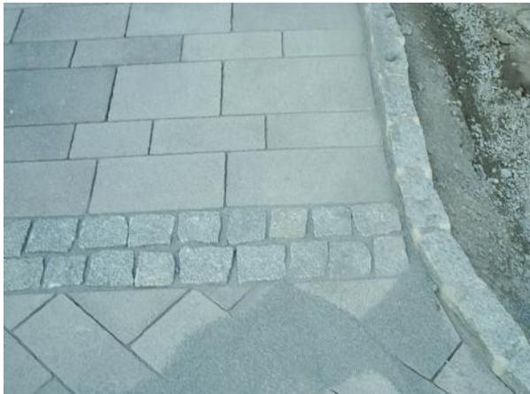
Hier sind sie bereits eingefügt. Schließlich werden die Fugen mit feinem Sand gefüllt, damit Wasser zwischen den Steinen versickern kann.
