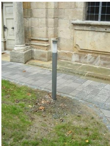
Fertig! Die Leuchte ist befestigt, Erde angefüllt.
