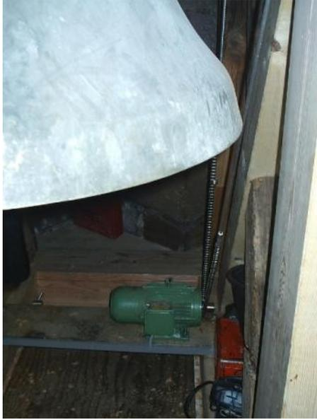
Hier ist einer der Motoren schon installiert. Es wird noch bis Ostern dauern, bis das ganze Läute- und Schlagwerk wieder in Betrieb genommen werden kann.
