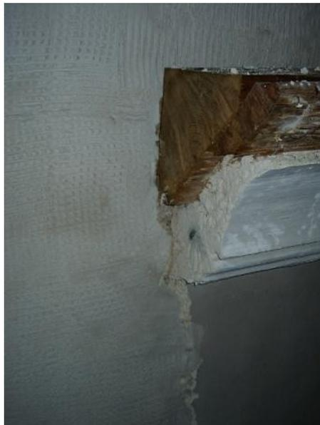
Denn durch die Entfernung der schadhafte Stücke endet das Gesims ja zur Zeit im Leeren und ist deshalb nicht so stabil, wie es sein sollte.
