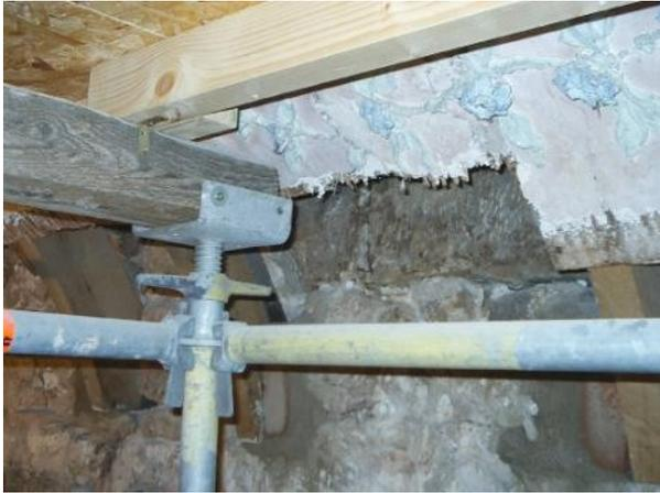
Bis tief in den kostbaren Stuck hinein musste vom Schwamm befallenes Material abgebaut werden.
