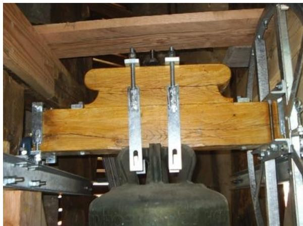
Hier noch einmal die Flachbänder. Das Eichenholz wird noch ein wenig schwinden. Über die Schraubgewinde kann man dann die Befestigung nachziehen.
