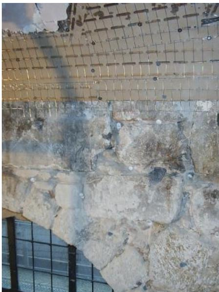
Auf diesem Bild ist das engmaschige Netz dieser Einfüllstutzen zu erkennen.
