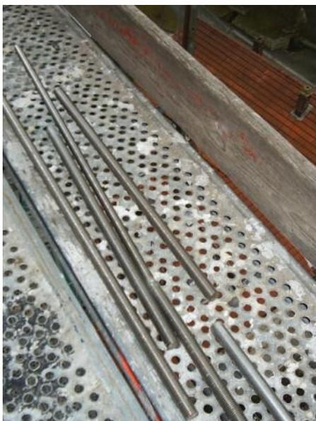
Und um alles ganz sicher zusammenzuhalten, auch wenn durch schwingende Glocken sich alles etwas bewegt, wurden Gewindestangen durch den Glockenstuhl geführt. Verschraubungen geben den nötigen Halt.
