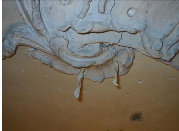
Damit diese Masse vor dem Abbinden nicht herausläuft, wurden die Löcher mit diesen Papierstöpseln verschlossen. Aber auch Schrauben sichern den Stuck an der Holzdecke.
