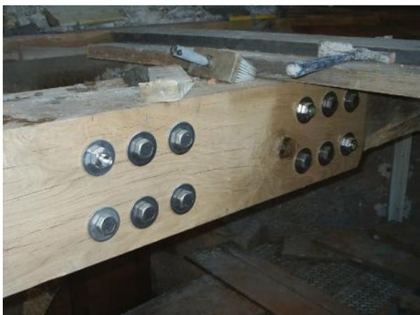
Zwölf starke Schrauben halten alt und neu zusammen, so dass die nötige Tragfähigkeit gewährleistet ist.
