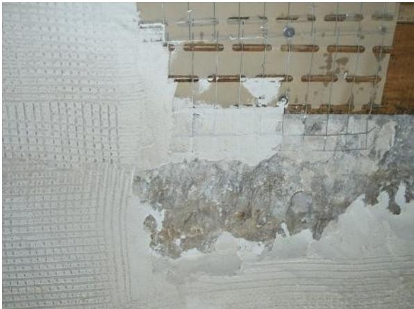
Im zweiten Durchgang geht es feiner zu: Die Flächen sollen ja wieder glatt werden. Hier sehen wir den Übergang zwischen Mauerwerk und Putzträger.
