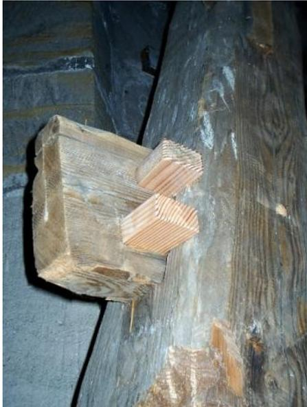
Zusammengehalten wird die ganze Konstruktion im wesentlichen durch solche Zapfen-Verbindungen.
