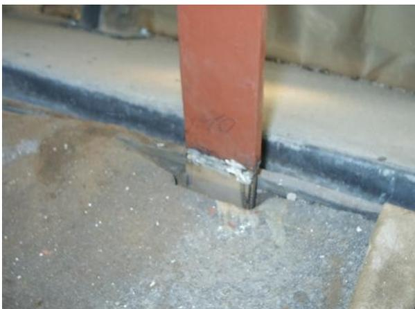
Am Übergang zur steinernen Fensterbrüstung waren die Eisenstege teilweise abgerostet. Hier mussten die Anschlüsse angeschweißt werden.
