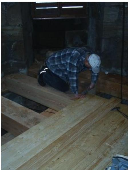
Die nächste Schicht ist nun der eigentliche Bretterboden, der hier verlegt wird.
