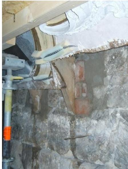
Hier ist eine der neu eingebauten Spanten zu erkennen. Die Lücke daneben wurde zugemauert.
