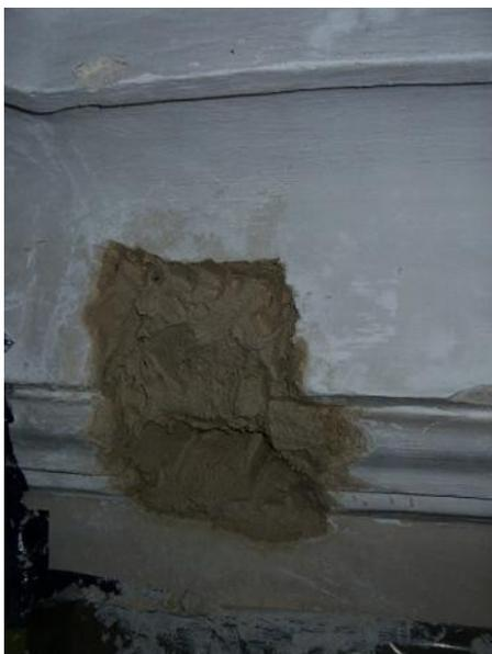
Dann wird im nächsten Arbeitsgang grob zugeschmiert. Erst wenn alles gut durchgetrocknet ist, kann das glatte Profil nachgezogen werden.
