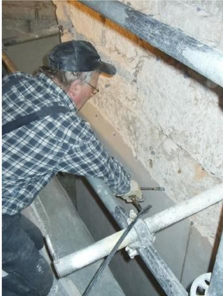
Eine den Pilz tötende Chemikalie wird dazu unter hohem Druck ins Mauerwerk hineingepresst.
