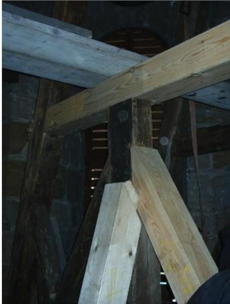
Hier ein Blick auf die Konstruktion: Alte, noch intakte Balken passen zusammen mit neuen und stützen sich gegenseitig.
