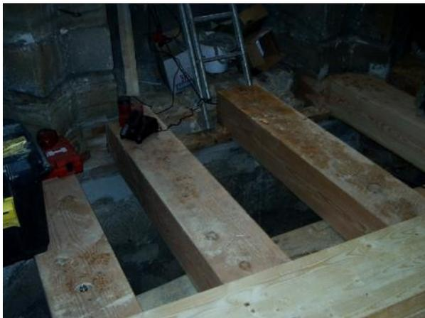
Auch hier sorgen große Schrauben für eine stabile Verbindung mit den tragenden Eichenbalken.
