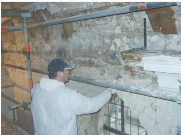
Der Restaurator kratzt vom Schwamm befallene Mörtelfugen heraus. Denn wenn das Pilzgewebe in der Mauer bleibt, kann es – mit ein wenig Feuchtigkeit – nach Jahren wieder aktiv werden.
