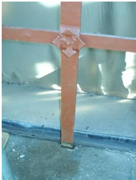
Auf diesem Bild ist hinter dem Fensterkreuz eine Metallrinne erkennbar: In ihr sammelt sich das am Fenster herunter laufende Kondenswasser und wird über ein Röhrchen nach außen geleitet – eine pfiffige Konstruktionsidee aus der Barockzeit, um die Feuchtigkeit vom Gebäude weg zu bekommen.
