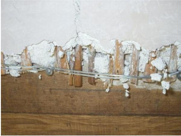
Der alte Stuck hängt ja an einer Schilfrohrmatte – auf diesem Bild gut erkennbar. Um die losen Schilfrohre zu sichern, werden sie vor dem Verputzen fein säuberlich mit Stahldraht befestigt, der dazwischen um die Schraubenköpfe gewickelt wird.
