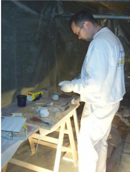
Damit die schweren Stuckfrüchte auch wirklich an der Decke halten, werden sie angebohrt und mit einer Edelstahlschraube im Holz befestigt.
