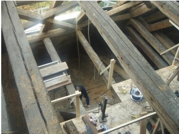
Ein Blick von oben auf den Arbeitsplatz der Zimmerleute.
