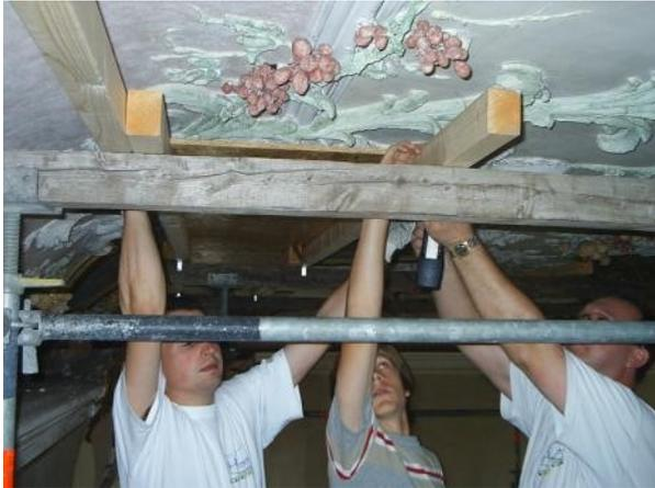
Damit sich keine Stuckteile lösen und von der Decke stürzen, wurde im fraglichen Bereich ein Stützgerüst aufgestellt und die Stuckdecke in Schaumstoff verpackt. Hier sind die Restauratoren beim Einbau dieser Sicherungsschalung.
