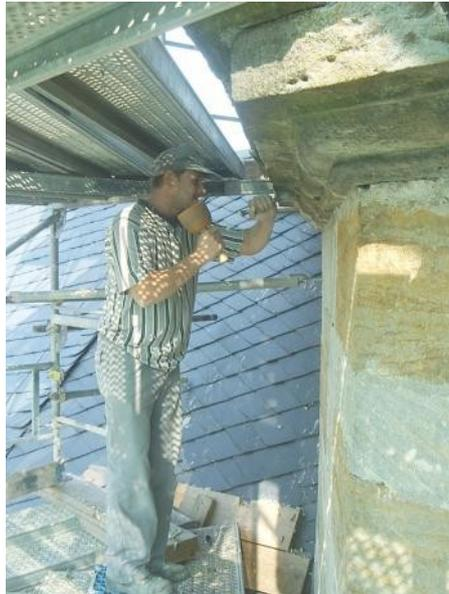
Aber auch die Steinmetzfirma Kneisl hat mit der Arbeit begonnen. Der erste Schritt für die Sanierung ist das Aufschlagen lockerer Fugen zwischen den Sandsteinen. Das geschieht in Handarbeit, hier an einem mittleren Turmgeschoß.
