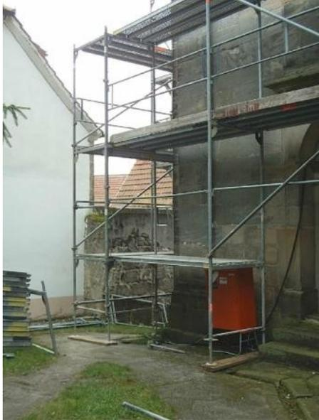
Eine Etage nach der anderen wird aufgebaut. Damit das Gerüst nicht zu sehr wackelt, wird es mit dem Mauerwerk verschraubt.
