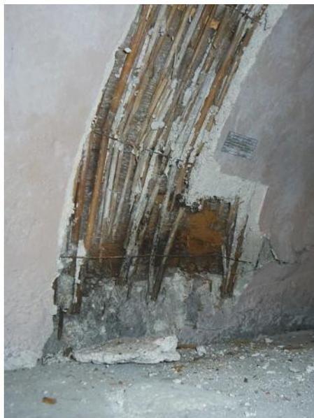
Hier sieht man die ganze Konstruktion: Eine Schilfmatte wurde auf die Schalungsbretter der Decke genagelt. In die Zwischenräume "krallt" sich gewissermaßen der Putz hinein. Das ist die ganze Befestigung.
