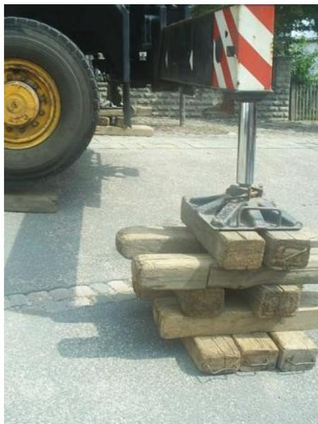
Ein gigantischer Kran musste anrücken, um die Glocken aus dem Turm zu heben. Hier der Unterbau unter den Ausleger - notwendig, um die Schräge des Geländes auszugleichen.
